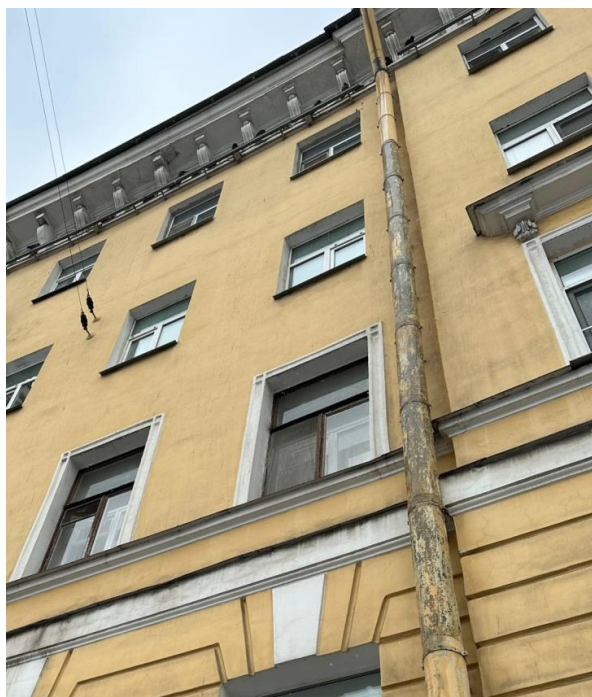
Рис. 3. Деревянные рамы окон на фасаде здания, выходящего на Московский проспект, точка проведения измерений №3.
