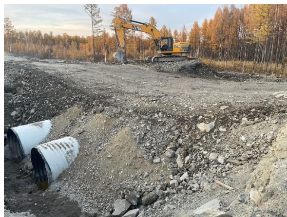
Рис. 7. Готовая МГТ под насыпью автобублера БАМ
