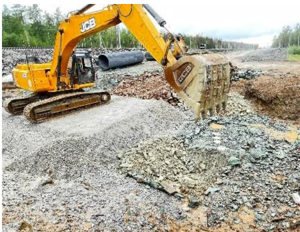
Рис. 4. Разработка основания (экрана) под оголовки МГТ
