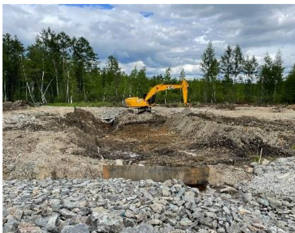
Рис. 2. Разработка котлована под укладку трубы
