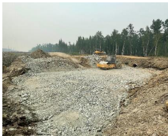
Рис. 3. Уплотнение замененного основания под МГТ
