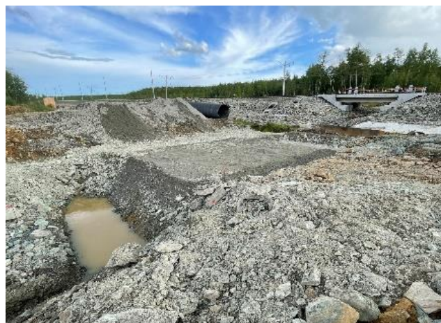
Рис. 5. Готовый котлован под оголовки МГТ
