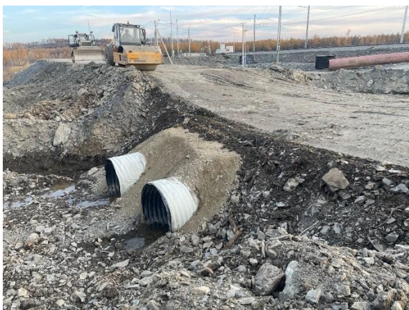
Рис.6. Засыпка и уплотнение насыпи над МГТ
