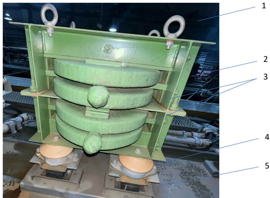
Рис. 1. Сухой сглаживающий реактор РСС:
