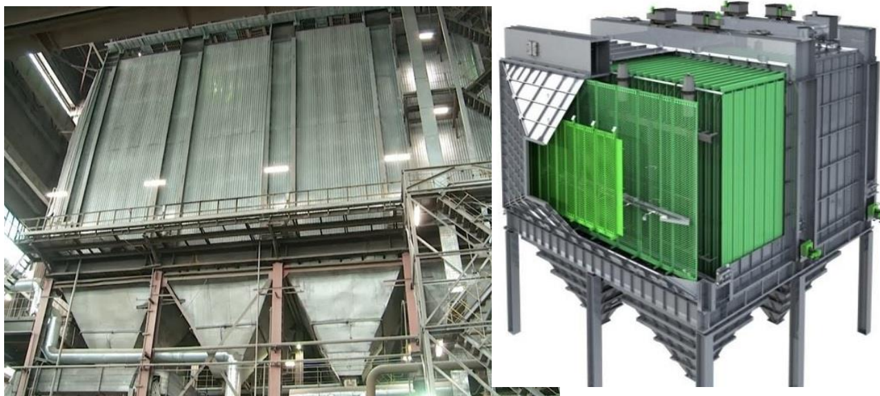
Рис. 1. Внешний вид электрофильтра и электрофильтр в разрезе
