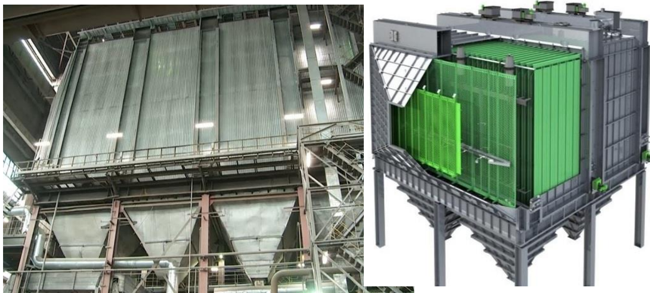
Рис. 1. Внешний вид электрофильтра и электрофильтр в разрезе
