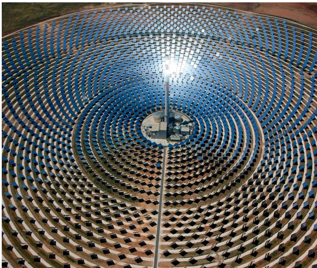
Рис. 2. СЭС с гелиоконцентратором
